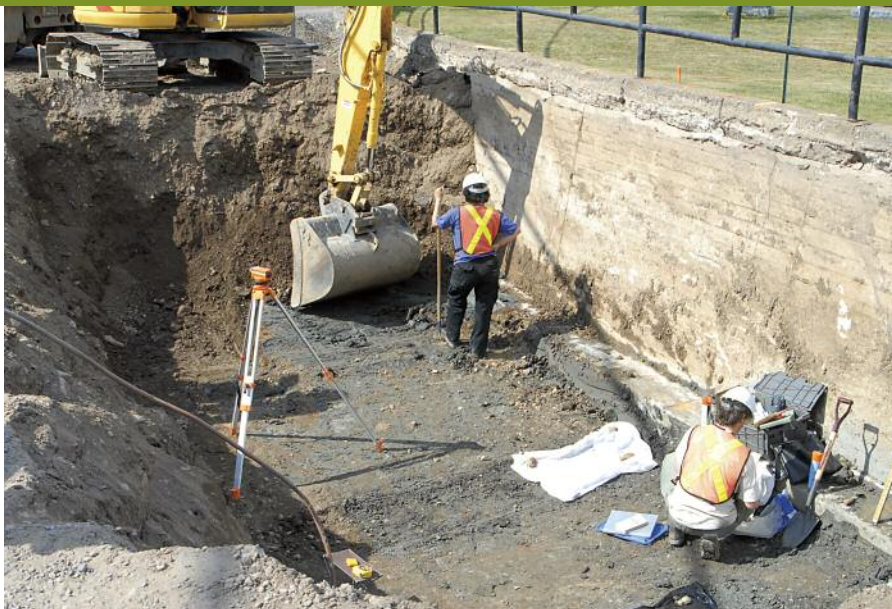
Supervision archéologique d'une excavation mécanique Rivière-Ouelle
